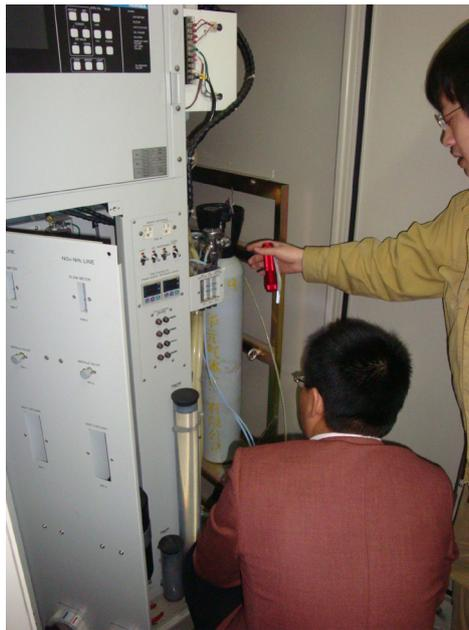
图4 中国某火力发电厂脱硝设备出口处的 NH<sub>3</sub> 逃逸率监测装置
